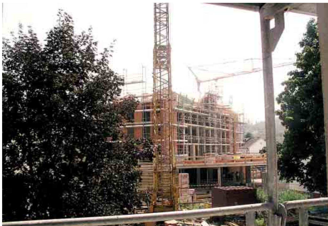
Im Erdgeschoss ist Raum für Läden, Praxen und Büros, auf einer begrünten Platte darüber befindet sich der Wohnbereich.
